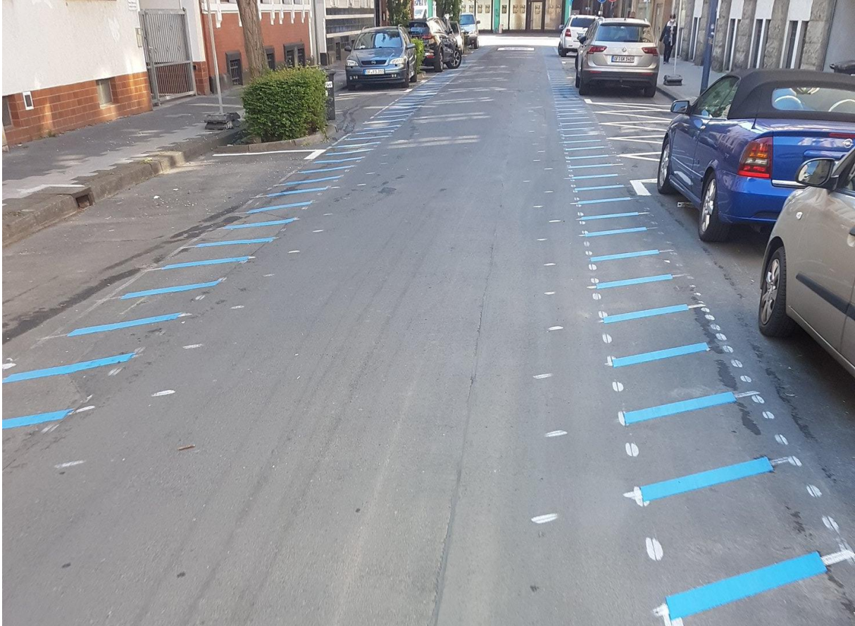
Projekt „Bike Offenbach“: Durchgehende Markierung des Sicherheitsstreifens / Türöffnungs-Zone Foto: Janina Albrecht
