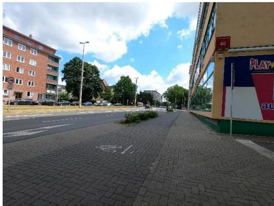
Radverkehr ist hier im Zweirichtungsverkehr unterwegs, die vorhandenen Pfeile sind nicht mehr sichtbar
