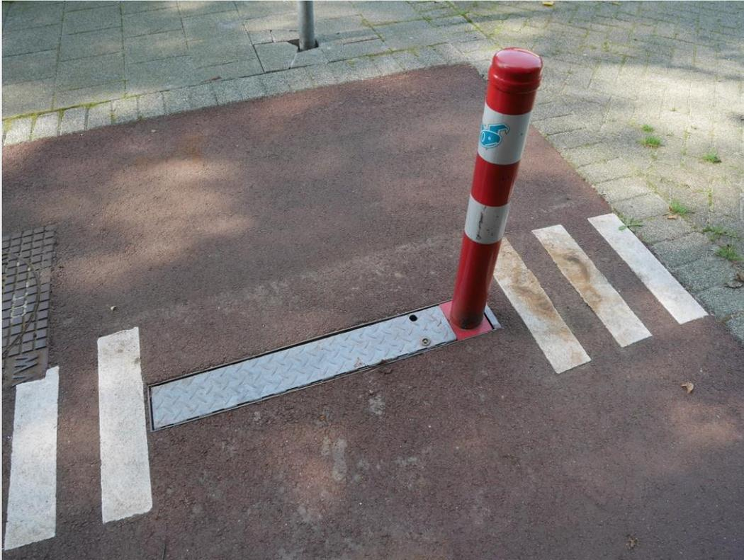
Die Markierungen vor dem Poller spürt man beim drüberfahren. Wenn der Poller umgeklappt wird, verschwindet er im abgedeckten Kasten.
