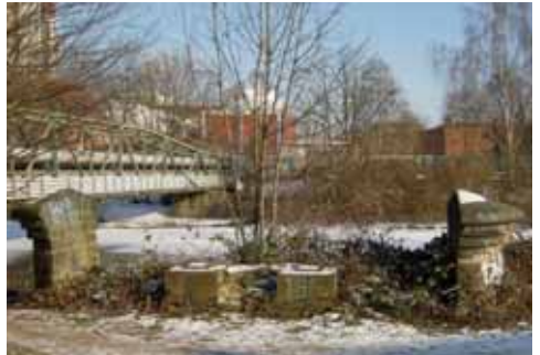
Nur die Fundamente der alten Eisenbahnbrücke über die Oker stehen noch. Sie sollen nach Möglichkeit in die neue Ringgleisbrücke integriert werden.
