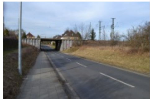
Eisenbahnbrücke am Brodweg Richtung Norden
