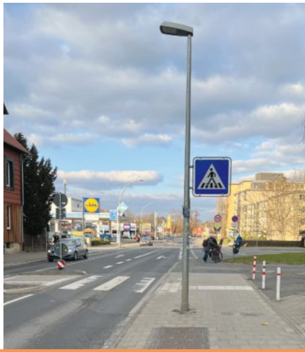
Beispiel eines Mangels: Wieso steht ein Lichtmast mitten auf dem Radweg?
