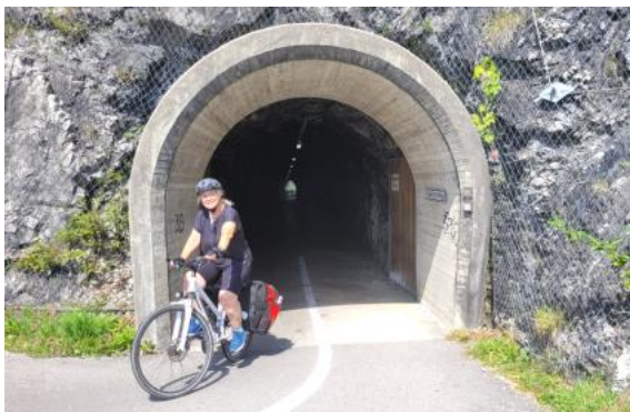
Ehemaliger Eisenbahntunnel an der Ache
